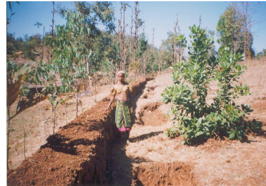
Trench cum Bund
